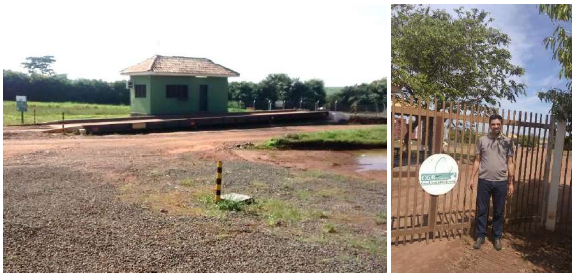
Imagem 4: Portaria com vigilância e balança (à esquerda). Portão de controle de entrada do aterro sanitária do CGR (à direita).
